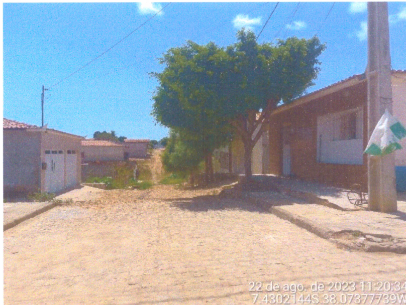
Rua Antônio Padre de Azevedo (Pavimentação)
